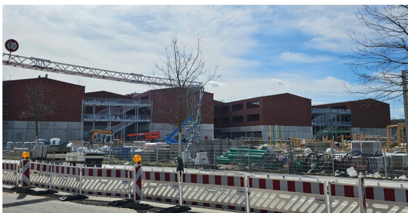
Bau der Gemeinschaftsschule in Adlershof
