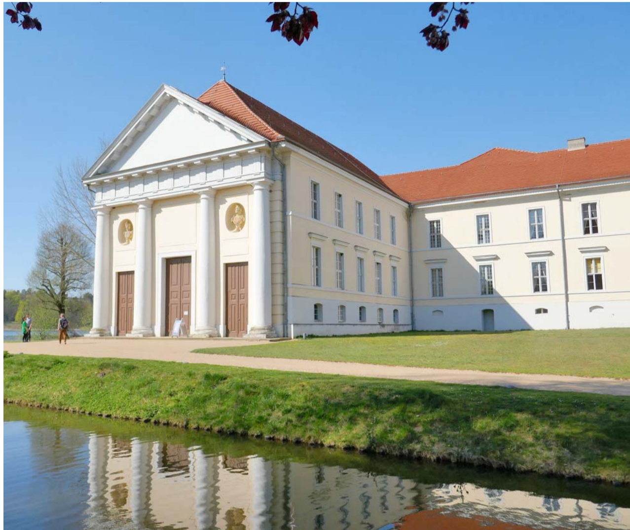
Rheinsberg: In die Sanierung des Schlosses flossen auch europäische Fördermittel.
